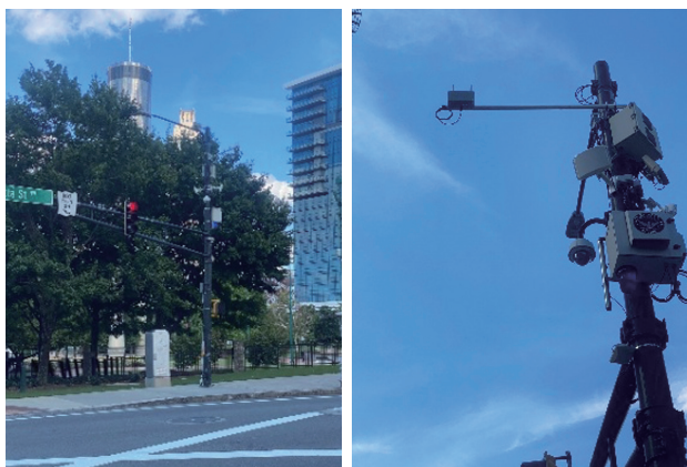
図表6-1-7 交差点に設置されたV2Xインフラ装置点
