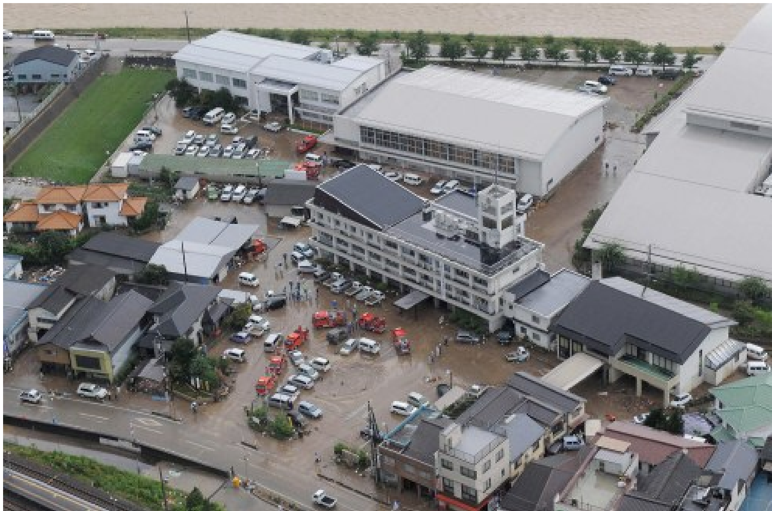
1階が冠水した佐用町役場 2009年8月10日
